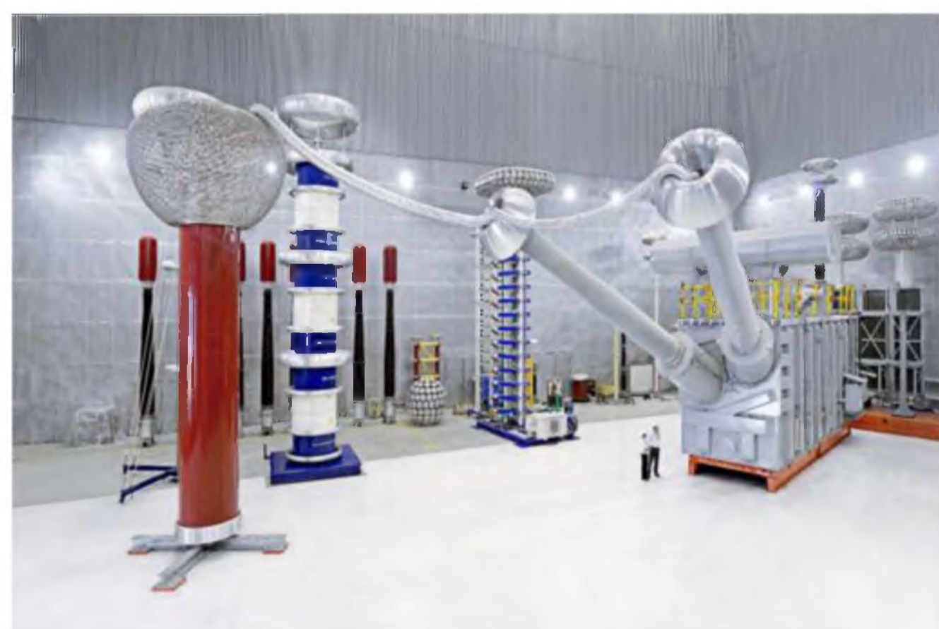
Испытание трансформатора постоянного тока
