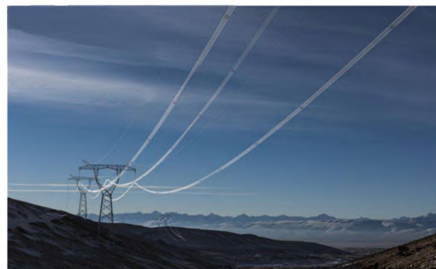
Пилоны высоковольтной ЛЭП постоянного тока Чанци – Гугуан
