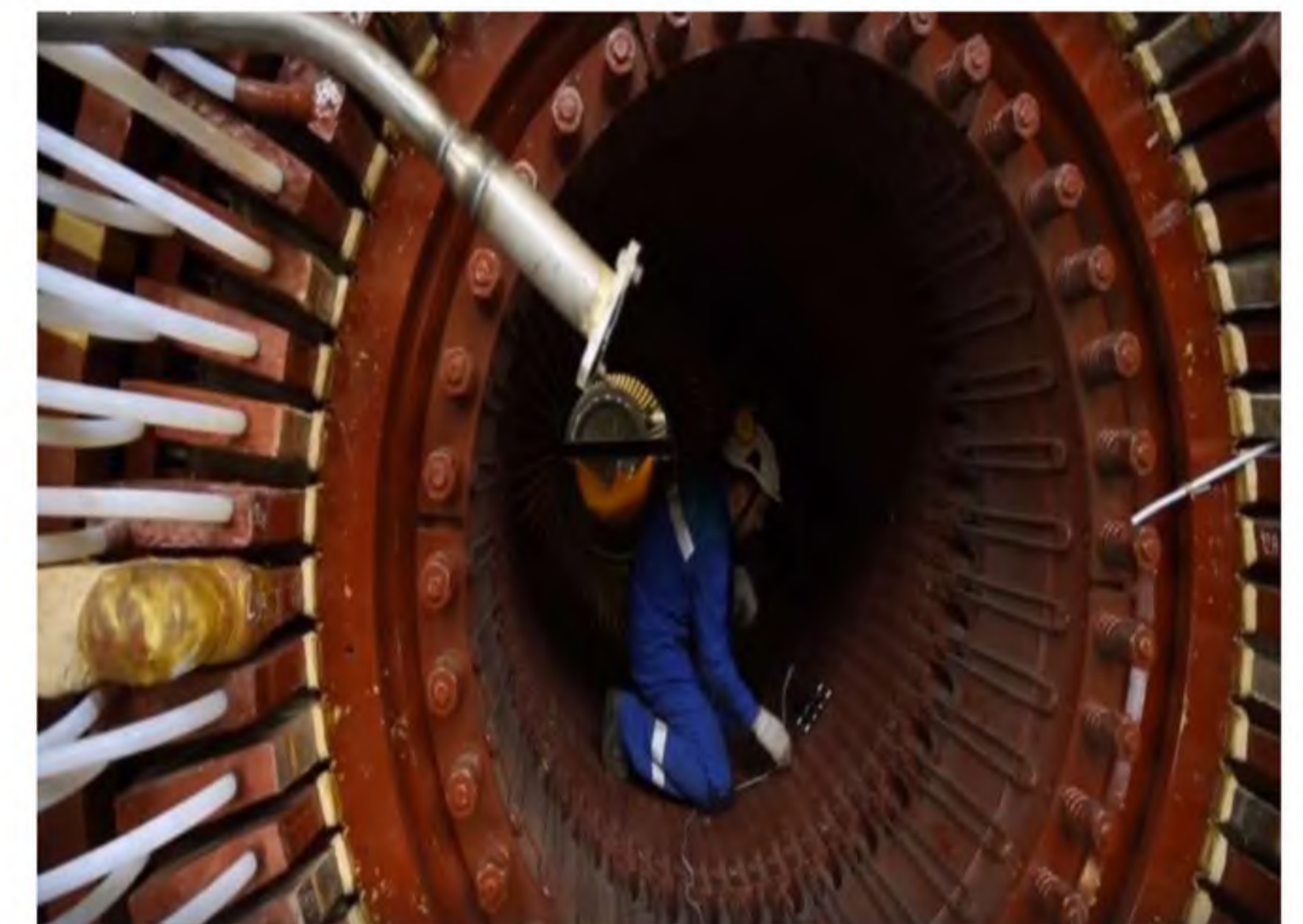
Проверка статора на межфазное КЗ на Нововоронежской ГРЭС
