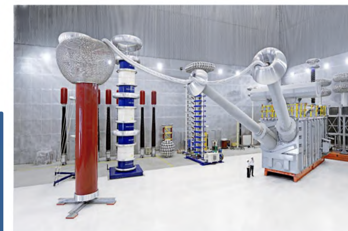
Испытание трансформатора постоянного тока
