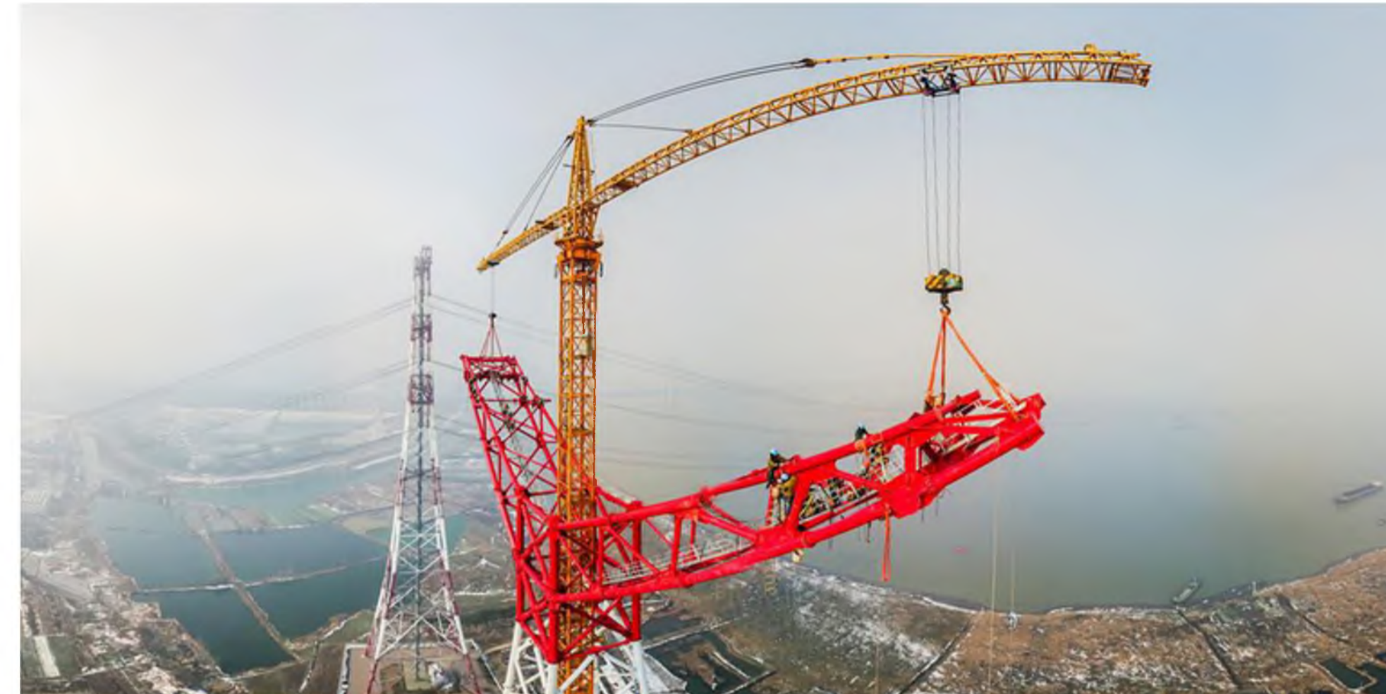
Строительство пилона высоковольтной ЛЭП постоянного тока Чанцзи – Гугуан
