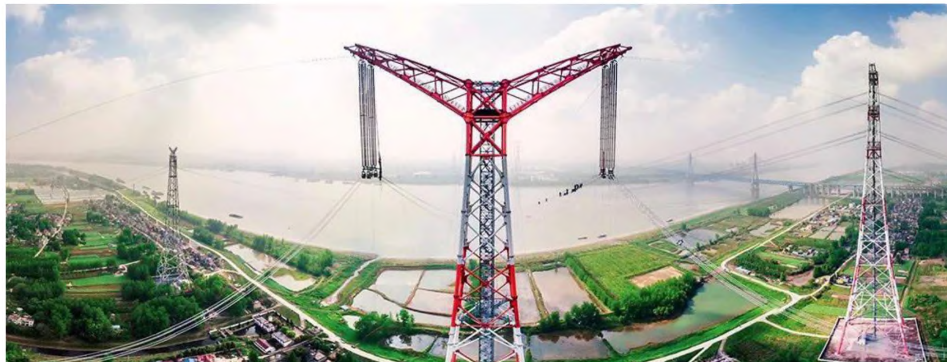
Пилон высоковольтной ЛЭП постоянного тока Чанцзи – Гугуан (провинция Цзянсу, Восточный Китай)
