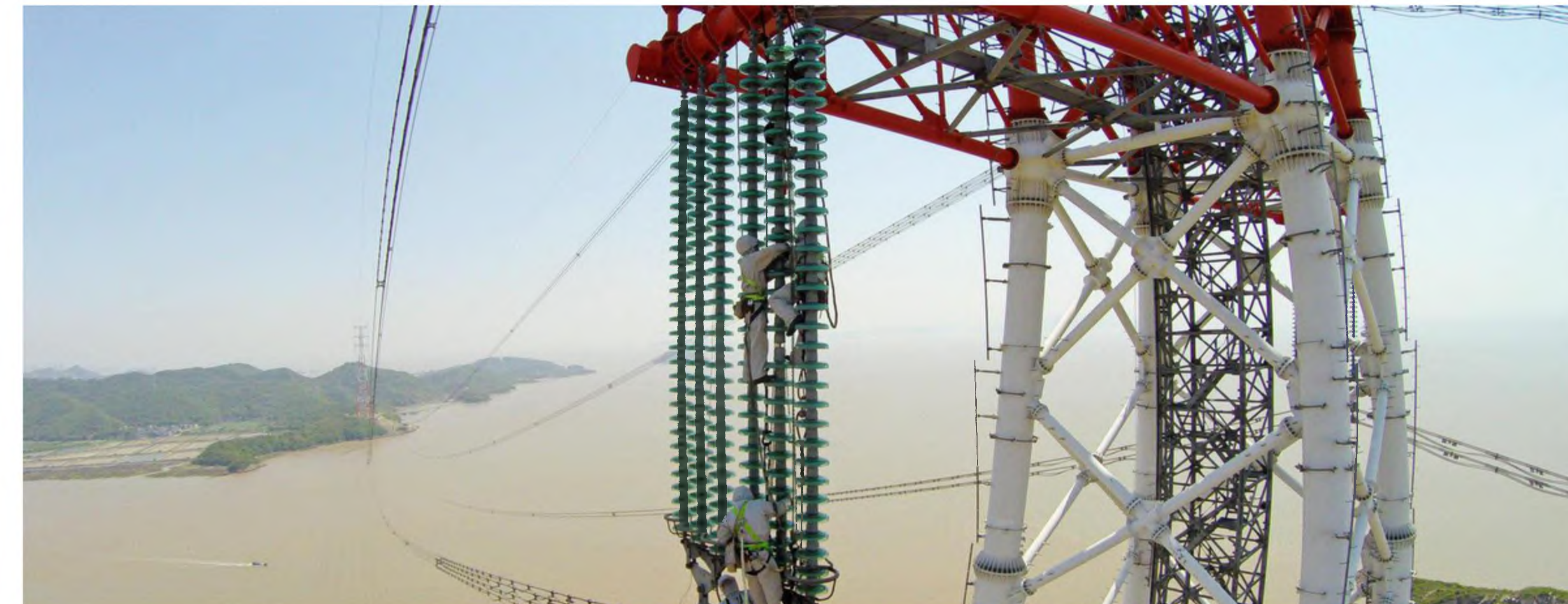
Установка гирлянд изоляторов из закаленного стекла на пилон высоковольтной ЛЭП постоянного тока Чанцзи – Гугуан
