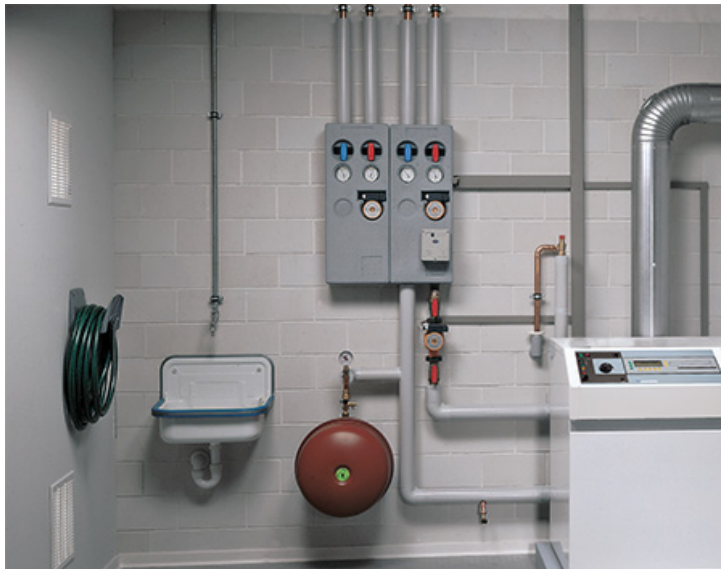
Рис. 4. Установка котельного оборудования в жилом помещении
