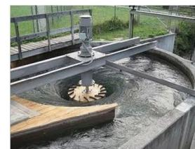
Рисунок 6. Водоворотная микро-ГЭС
