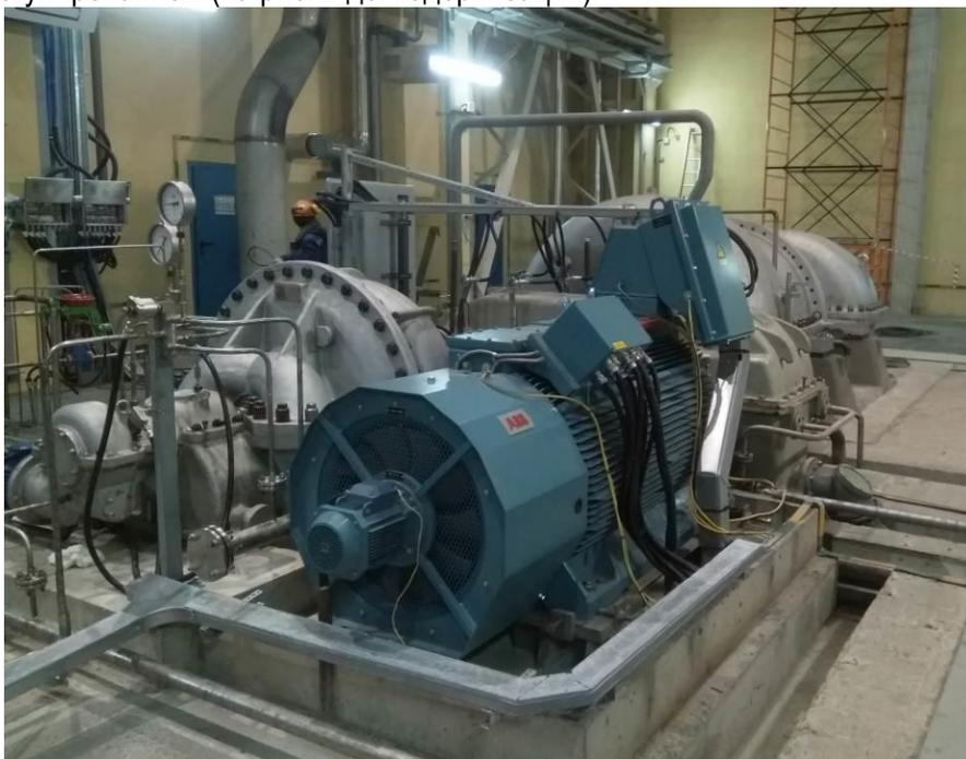
*Рис. 3. Реализованное техническое решение по замене привода*
