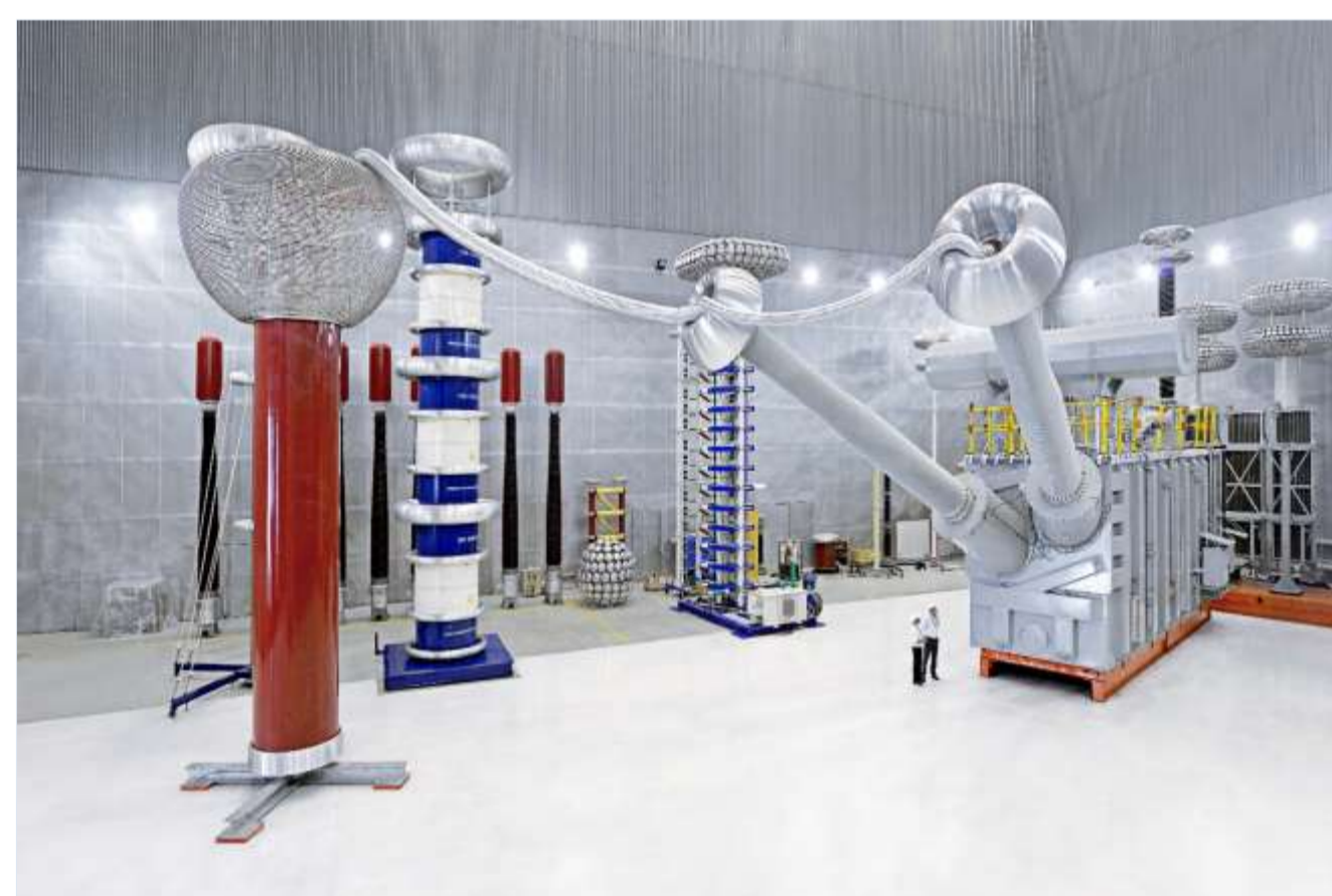
Испытание трансформатора постоянного тока
