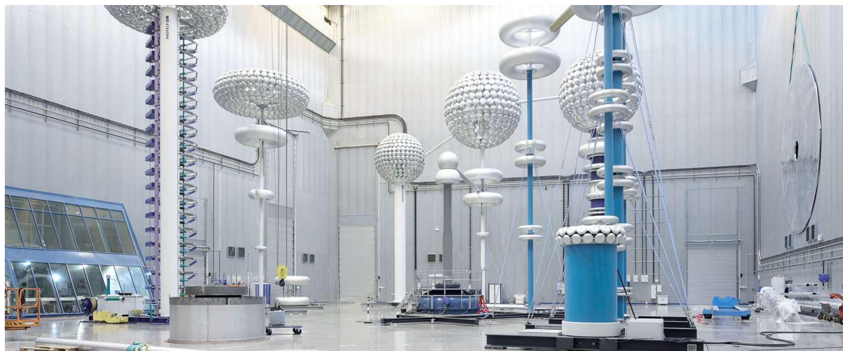
Лаборатория для испытания работоспособности высоковольтного оборудования
