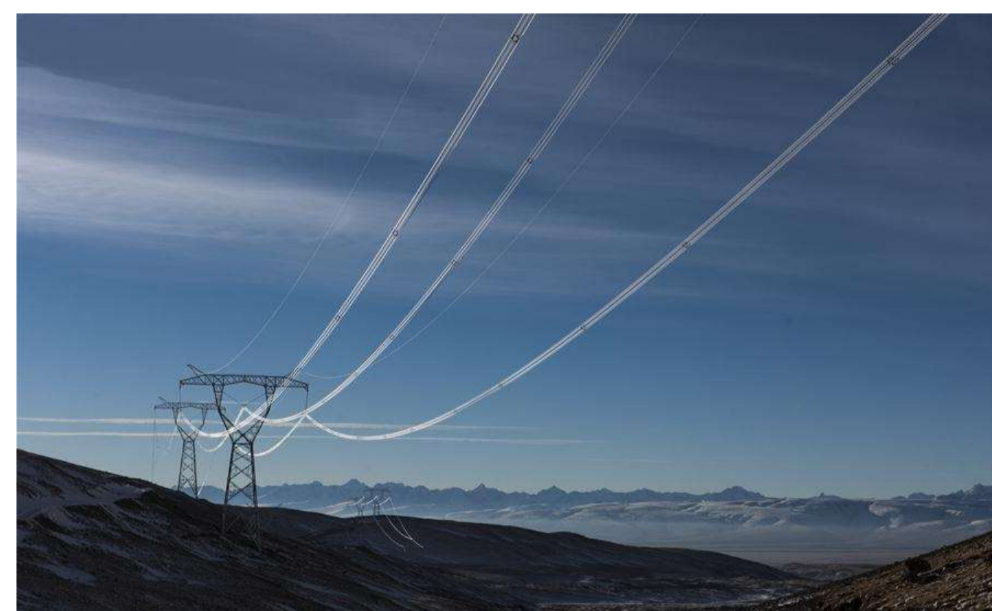
Пилоны высоковольтной ЛЭП постоянного тока Чанци – Гугуан
