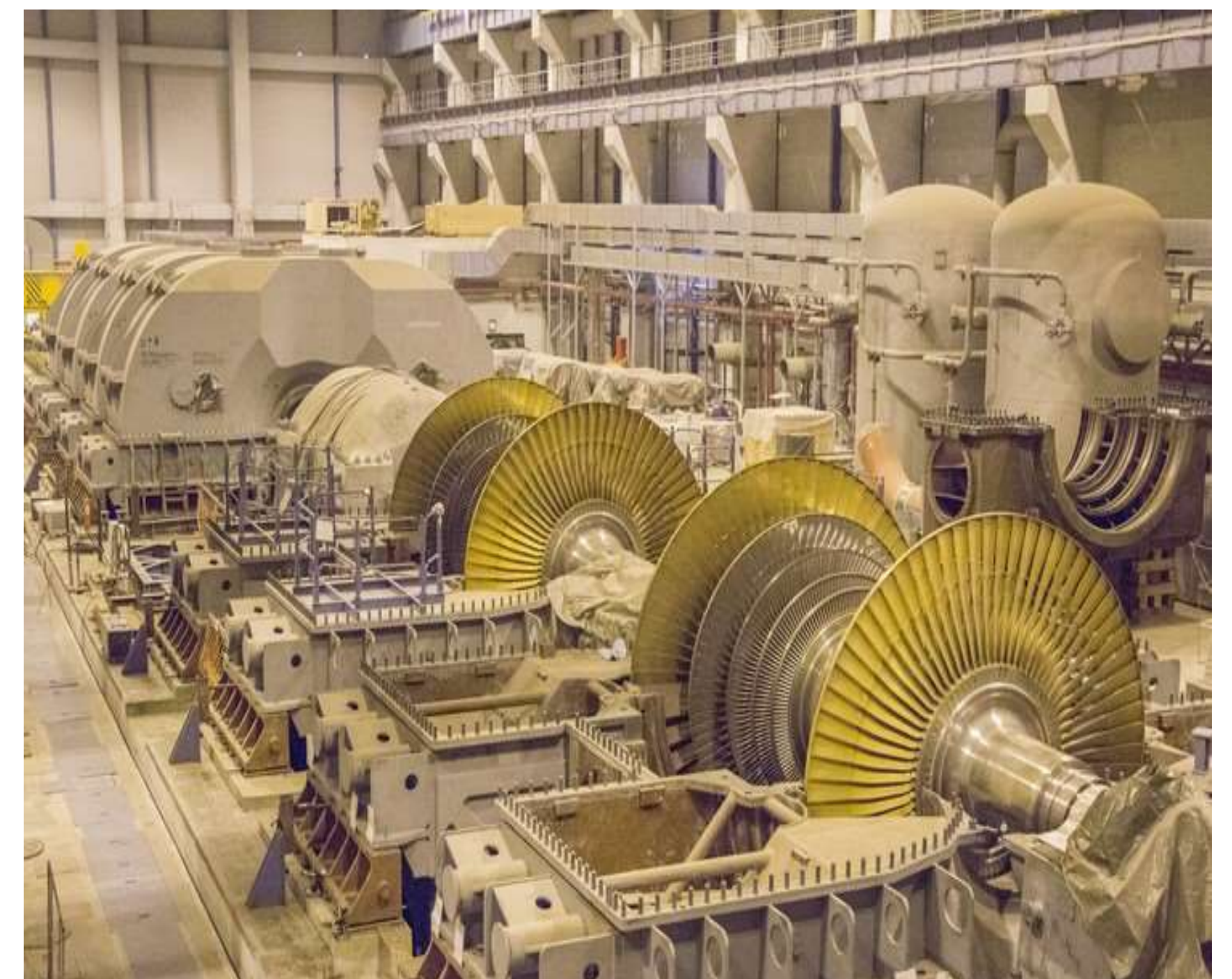
Строительство машинного зала на ЛАЭС-2
