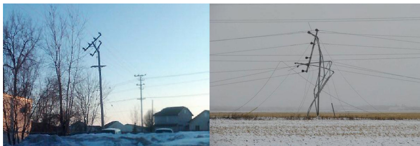
Рис. 1. Повреждение столба: а – из-за возгорания; б – из-за галоупирования
