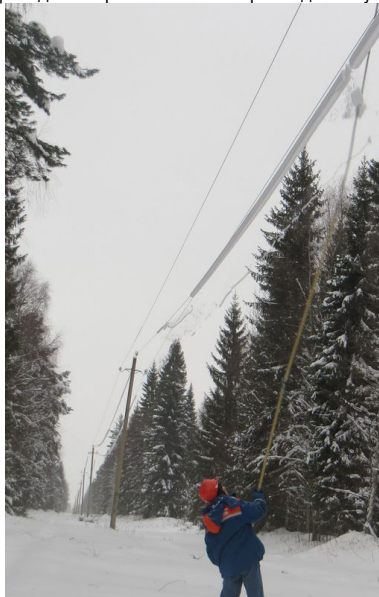
Рис. 1. Сбивание изморозевых отложений с проводов
