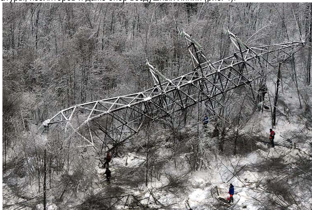
Рис. 4. Последствия гололеда для линий электропередач
