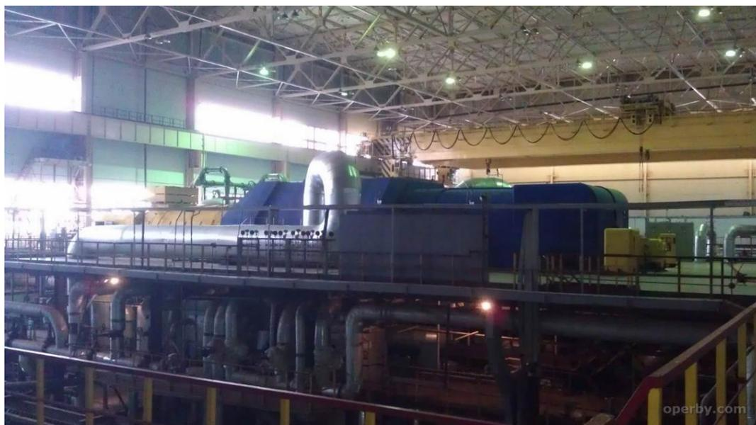
Рис. 1. Турбоагрегат мощностью 320 МВт
