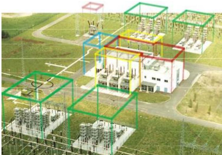
*Рис. 2. Вставка постоянного тока на базе двух СТАТКОМ на трансформаторной подстанции*
