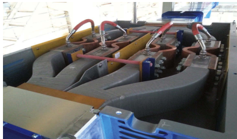
Рис. 3. Соединение двух элементов шинопровода при помощи компенсаторов тепловых расширений
