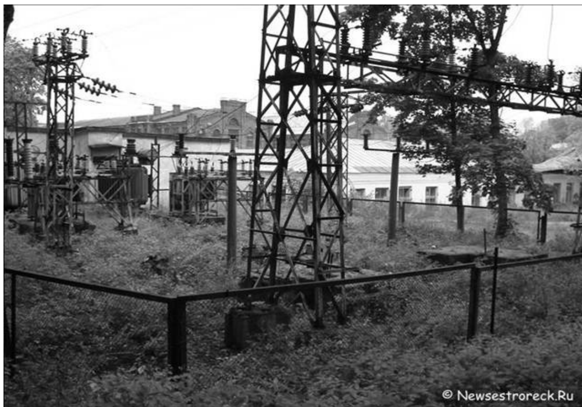
Рис. 1. Сестрорецкий инструментальный завод. Главная понижающая подстанция
