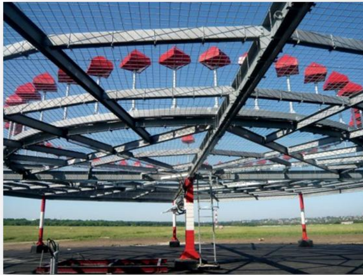
Рисунок П4.6 – Внешний вид наземного оборудования азимутального доплеровского радиомаяка DVOR 2000
