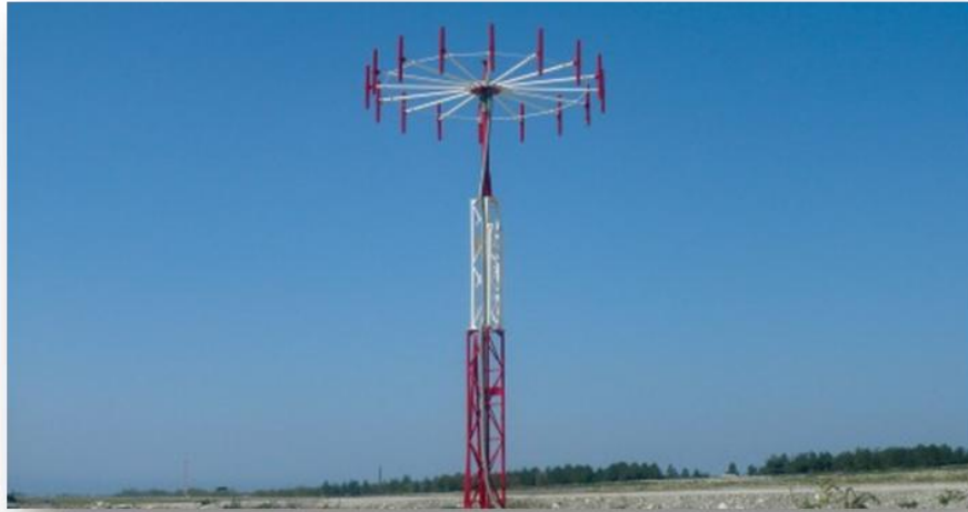
Рисунок П4.3 – Внешний вид выносной аппаратуры и мачты автоматического радиопеленгатора DF 2000
