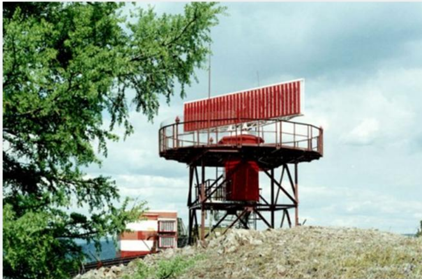
Рисунок П4.7 – Внешний вид наземного оборудования моноимпульсного вторичного радиолокатора «Крона-М»
