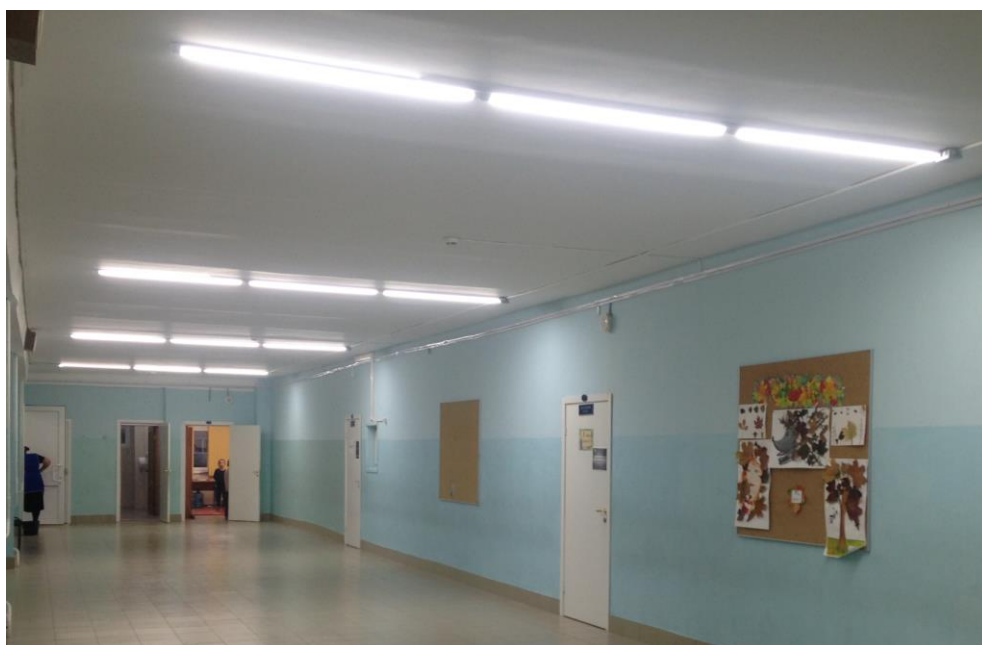
Рисунок 2.3 – Фото светильника РРО 1200/L 40W с места установки
