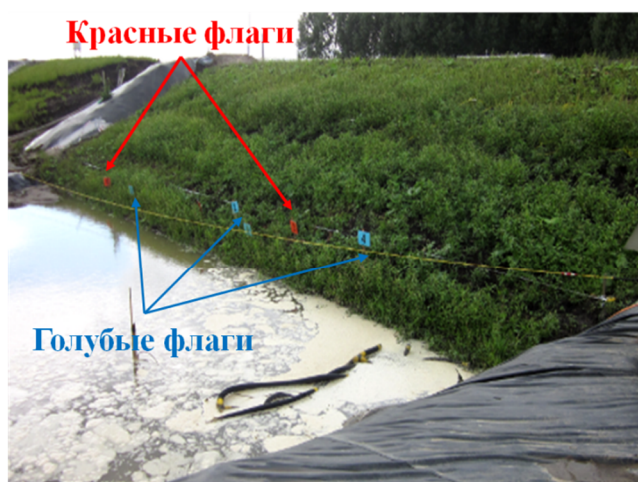
Рисунок 73 — Процесс разрушения «Восточной дамбы»: а — первые просачивания воды через дамбу: 26.08.2012 в 15:17; б — трещины в дамбе 27.08.2012 в 10:10
