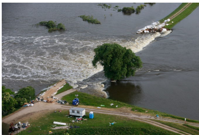
Рисунок 1 — Прорыв дамбы на реке Эльба, Германия, земля Саксония-Анхальт, 15 июня 2013 г. [14]
