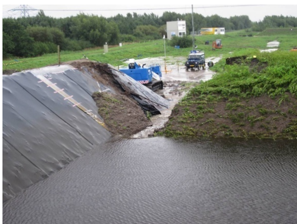
Рисунок 74 — Прорыв «Восточной дамбы» 27.08.2012 в 11:30
