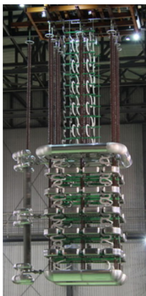
Рис. 2. Изображение преобразовательного клапана ультравысокого напряжения \pm 1100 кВ
