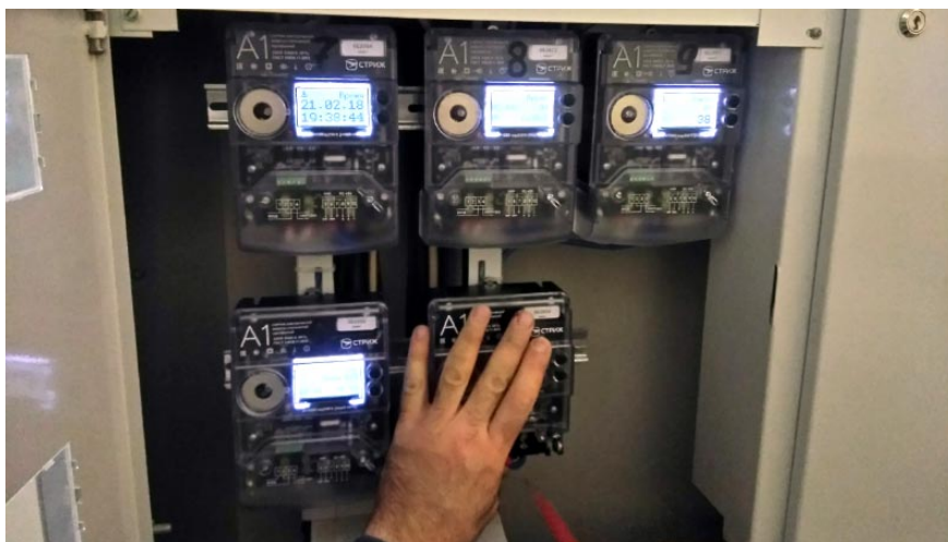
Рис. 2. Умный электросчетчик АСКУЭ «СТРИЖ»
